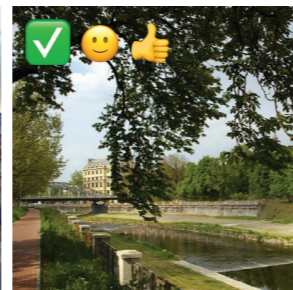
Úprava řeky Ostravice cyklostezky, loděnice, galerie
